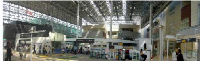
鉄道工区：新客札口周辺中央棟間方
