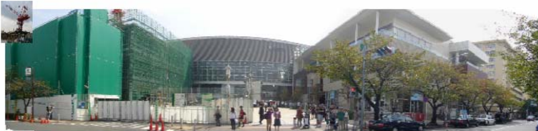
工期：鉄道工区：北口全棟
