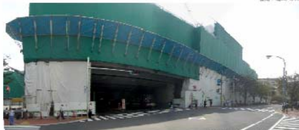
工期：北口バスロータリー：出入口付道
