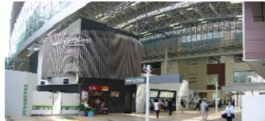
鉄道工区：新客札口周辺中央棟間方
