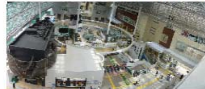
鉄道工区：新客札口周辺中央棟間方
