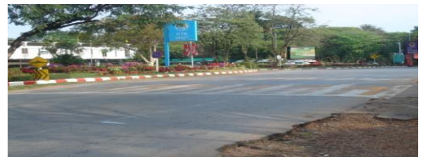
รูปที่ 3 เนินชะลอความเร็วหน้าคืออภิการบดิน มหาวิทยาลัยขอนแก่น ขนาด กว้าง 10.5 เมตร สูง 0.075 เมตร
