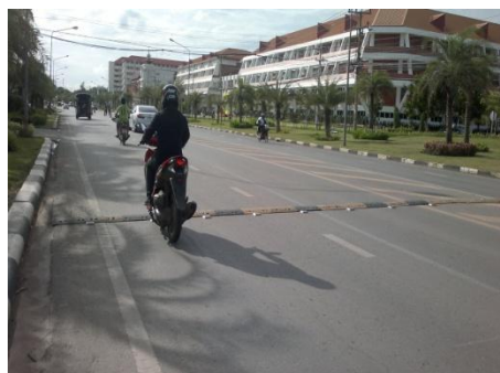
รูปที่ 2 บริเวณที่ติดตั้งยางชะลอความเร็ว (Rubber Speed bump)
