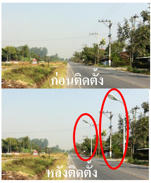
รูปที่ 13 ติดตั้งไฟฟ้าส่องสว่างให้เหมาะสม
