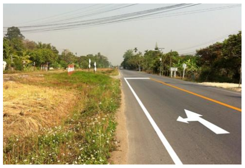
รูปที่ 11 สภาพเครื่องหมายจราจรบนพื้นทางที่ปรับปรุง (1)
