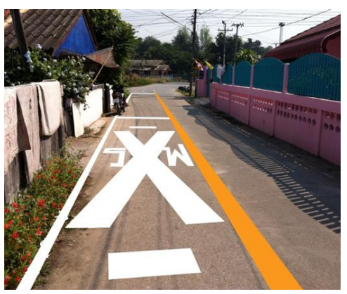
รูปที่ 11 สภาพเครื่องหมายจราจรบนพื้นทางที่ปรับปรุง (1)
