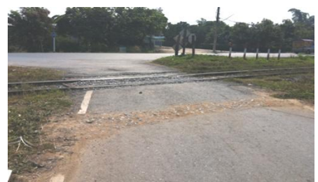
รูปที่ 4 ลักษณะความลาดชันของทางตัดผ่านทางรถไฟ จุดที่ 4
