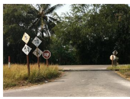
รูปที่ 6 สภาพป้ายจราจรเสื่อมโทรม
